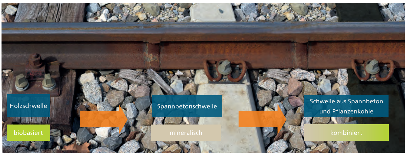
Entwicklung der Eisenbahnschwelle (v. r. n. l.): Traditionelle Holzschwelle, aktuell eingesetzte Spannbetonschwelle und zukünftig mögliche kombinierte Schwelle aus Spannbeton mit Pflanzkohle.
